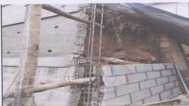
Foto 3: Reconstrucción de muro
