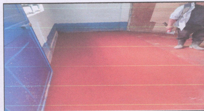
Foto 6: Fundición y alisado de piso rojo
