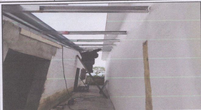
Foto1: Colocación de Estructura metálica y techo en pasillo
