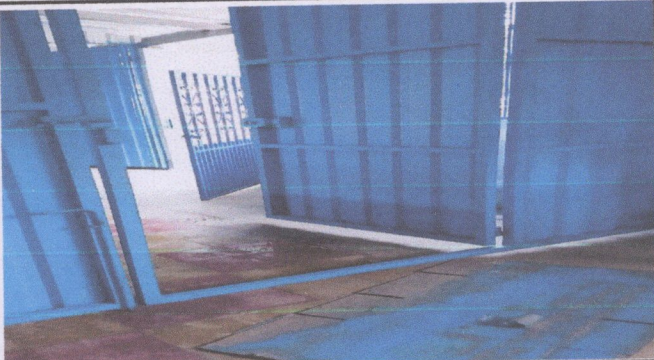
Foto 7: trabajo de sustitución de estructura y división de madera por metal
