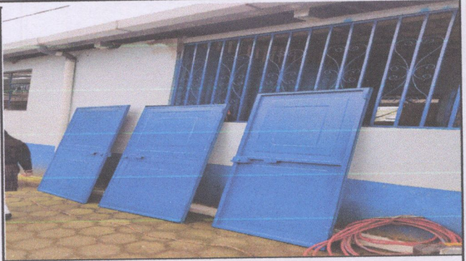
Foto 8: Sustitución de puertas
